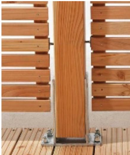
**Konstruktiver Holzschutz** ist das Qualitätsgeheimnis unserer Outdoor-Kollektion. Hier wird gut sichtbar, dass der Pfosten nicht im Nassen steht, sondern mit Abstand zum Boden und dadurch gut belüftet wird. Am oberen Ende sind die Pfosten pyramidenförmig, sodass das Wasser gut abläuft
